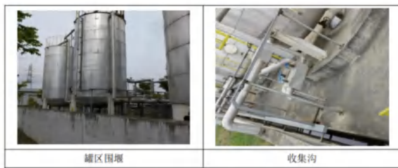
图 6.6-3 罐区围堰及收集沟
